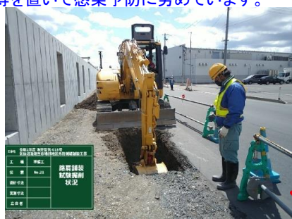
◎道路脇の土を採取して試験を行いました。
