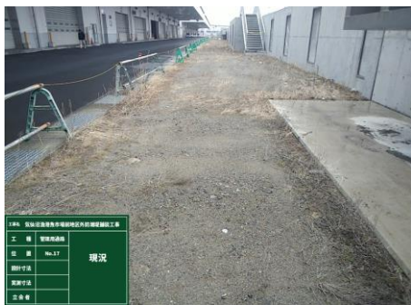
◎今回の工事区間内(№17～№23)の着手前の状態です。
