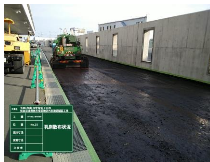
◎舗装をする前に安定性や防水性を高めるためアスファルト乳剤を散布しました。
