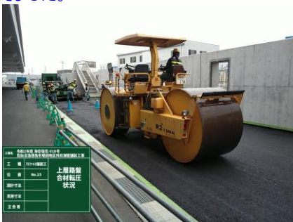
◎アスファルトをローラーで踏み固めています。
