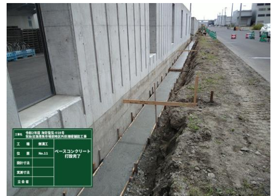
◎側溝の基礎コンクリートの打設が終わりました。
