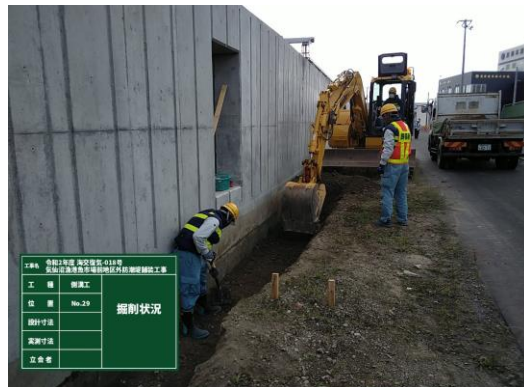
◎側溝の床掘りをしています。
