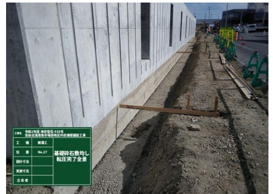
◎側溝の基礎砕石を施工しました。
