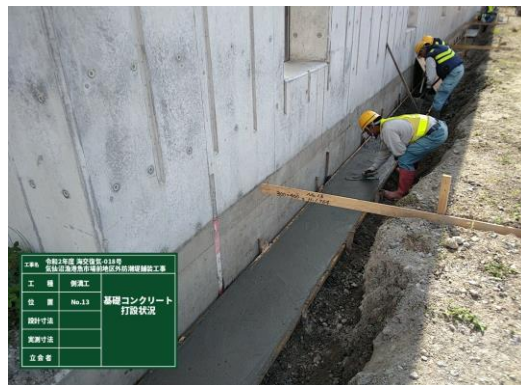
◎側溝の基礎コンクリートを打設しています。
