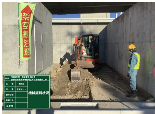
◎放流ゲート周りを掘削しています。
