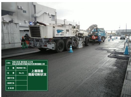
◎古い路面を平坦に削っています。
