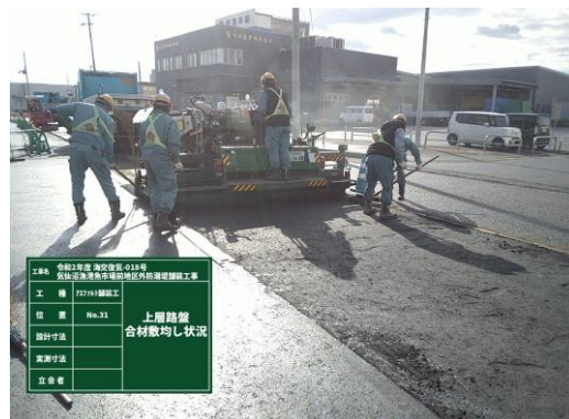
◎削った箇所の舗装復旧をしています。
