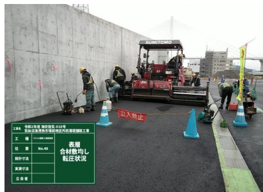
◎避難路の舗装をしています。
