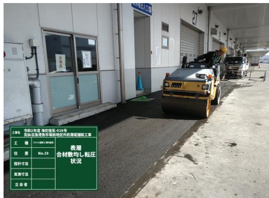
◎アスファルト舗装を敷均し転圧をしています。
