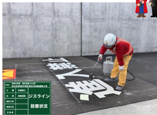
◎乗越道路に進入禁止のラインを引いています。
