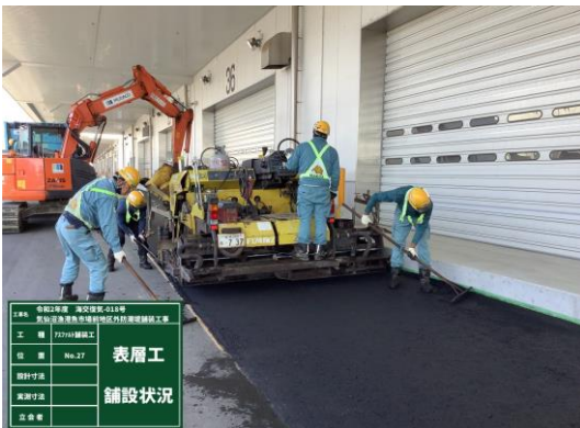
◎魚市場様の構内をアスファルト舗装しています。
