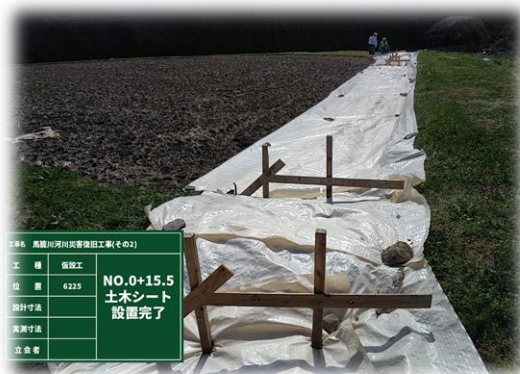
◎盛土する場所にシートを敷きました。
