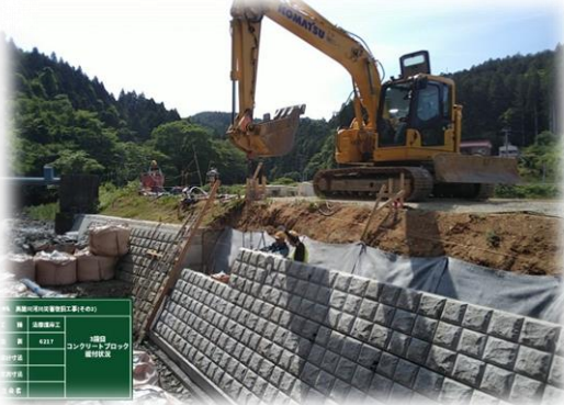
◎大型ブロックを据え付けています。
