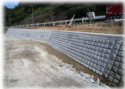
◎6221号 のブロックを据付けています
