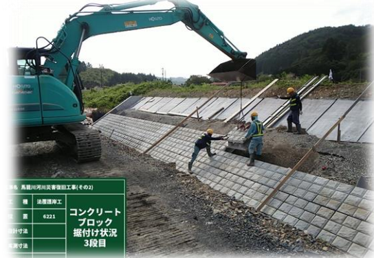
◎6221号 のブロックを据付けています
