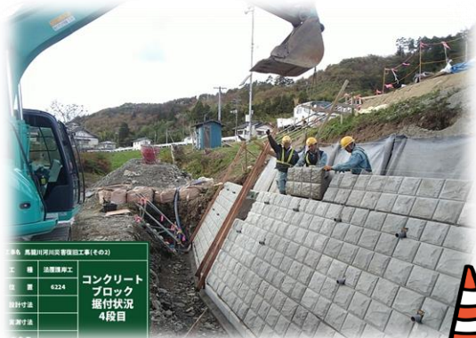
◎6224号の4段目のブロックを据え付けています
