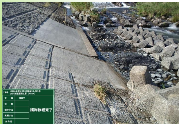
壊れた護岸ブロックの修繕が完了しました。
