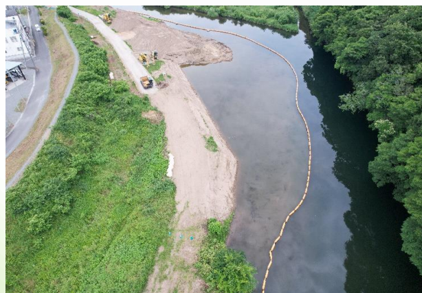
河川の堆積土砂撤去の進捗は約35%になりました。
